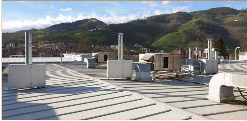
7. irudia- Orkli S.Koop. enpresaren hiru fokutan instalaturiko arazketa-sistemak.
