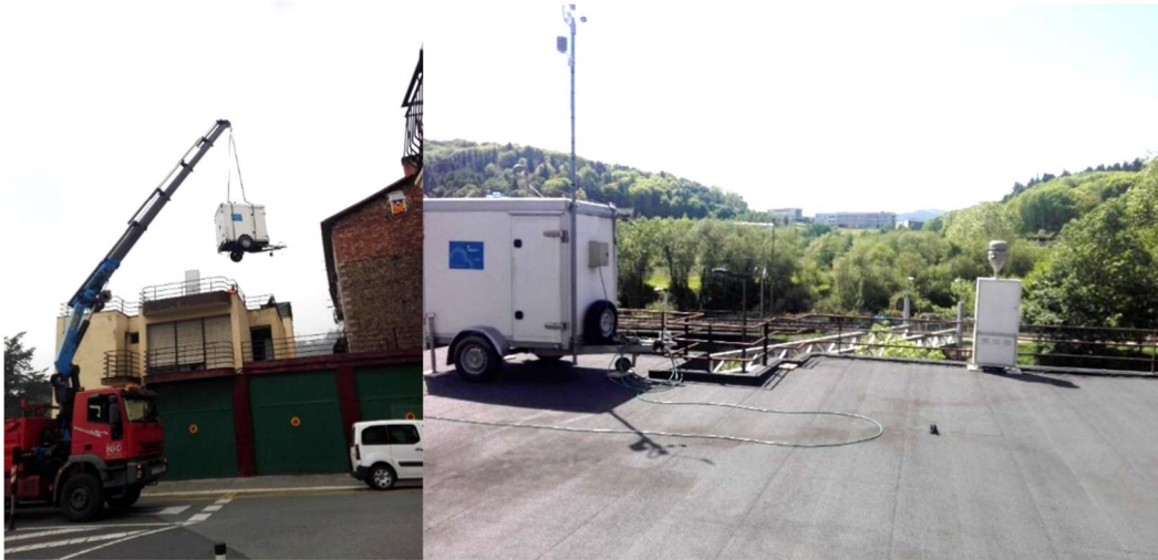
3. irudia- Ordiziako Suhiltzaileen eraikin zaharreko teilatuan kokatutako partikulen kaptadorea eta meteorologiarako unitate mugikorra instalatzeko lanak.
